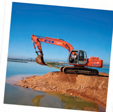
Disalatore Nubia - riparazione acquedotto
