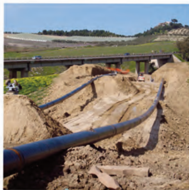
Rifacimento acquedotto Sela-Tragona
