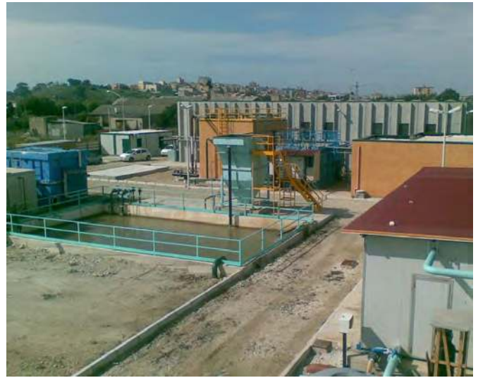
REALIZZAZIONE DELL'IMPIANTO DI POTABILIZZAZIONE DI GELA
