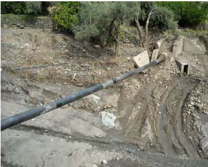
ACQUEDOTTO ALCANTARA INTERVENTO POST ALLUVIONE SUL TORRENTE FORAGGINE DI SCALETTA ZANCLEA
