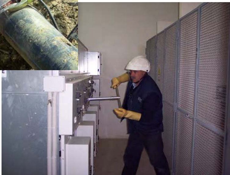
ACQUEDOTTO FAVARA DI BURGIO CENTRALE DI SOLLEVAMENTO "VILLASETA"
